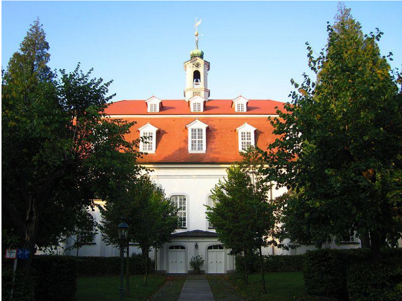
Kirchsaal der Brüdergemeine in Herrnhut, Foto: Rixxo
